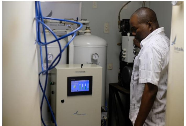
ကျန်းမာရေးဌာနများအတွက် ဆေးကုသမှုဆိုင်ရာ အောက်ဆီဂျင်ဓာတ်ငွေ့ကို cylinder concentrators နှင့် central pipeline system စသော ပုံစံအမျိုးမျိုးဖြင့် ရရှိနိုင်သည်။ ပုံ - PATH/Zachary Clarence
