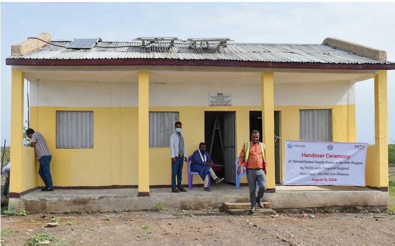
Un poste sanitaire rénové lors de sa cérémonie de réouverture en août 2024. PATH et Gavi, the Vaccine Alliance ont soutenu des réparations visant à rétablir les services de santé dans les zones touchées par le conflit.
